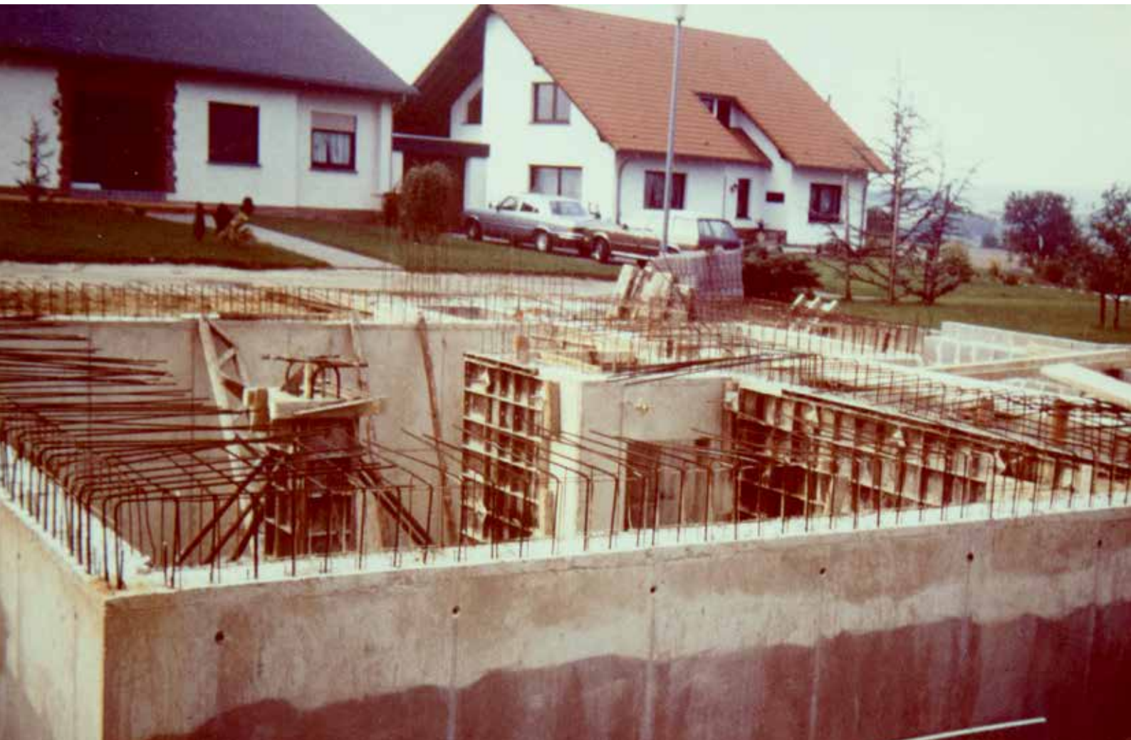
Auf einen Bunker kann man bauen! 1988 entsteht als Fundament des neuen Wohnhauses der öffentliche Schutzbau mit seinen 60 Plätzen. Das Entwidmungsverfahren haben die Eigentümer zwar eingeleitet, doch mit dem Überfall Russlands auf die Ukraine ruht es nun. Damit ist die Familie Eigentümerin von Deutschlands kleinstem, noch „aktivem“ Atomschutzbunker.
